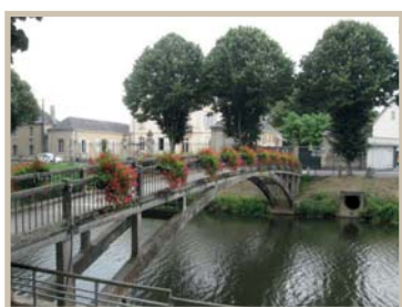
A Passerelle reliant le quai Victor Hugo au quai Poëy d'Avant
